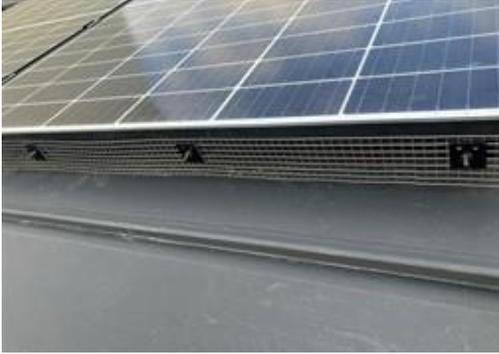
屋根の太陽光パネルのハト被害対策は、ステンレス金網でパネルと屋根との隙間を覆う方法が最適です。ハト除けガシット金具の使用で安価に設置できます。
