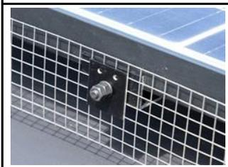
・屋根材上面と太陽光パネル迄の寸法を確認し、必要に応じ金網の寸法切りを行って下さい。
