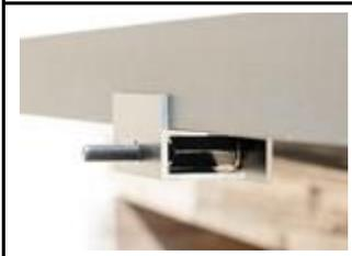
・固定金具の上部材の接着テープの離型紙をはがし、下部材のボルトに差し込み、太陽光パネルの側面に接着テープで仮止めます。
