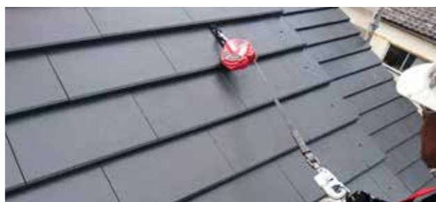
瓦屋根安全金具使用状況写真 - 親綱・安全ブロック・フルハーネス型墜落制止用器具 -
